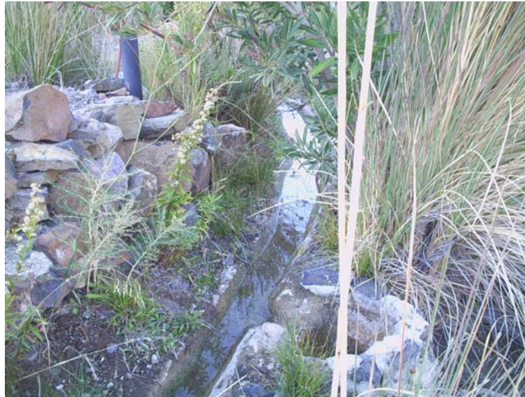
Acequia de derivación, paralela al cauce.
