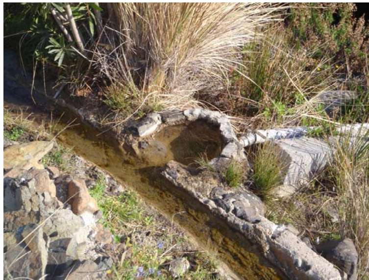
Derivación de agua hacia un deposito (Juan Carlos Rubio Campos)
