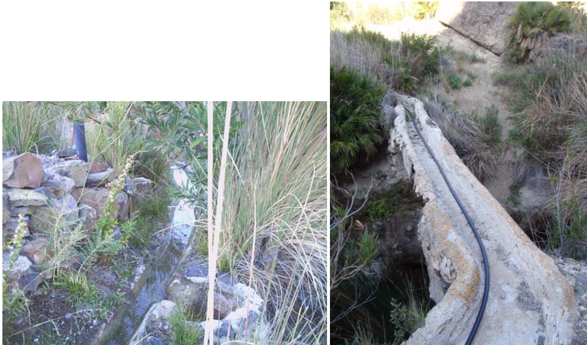
Acequia de derivación paralela al cauce (Jorge Jiménez Sánchez y Juan Carlos Rubio Campos, respectivamente)
