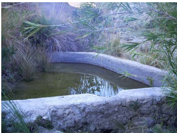
Estanque llenado con agua de la acequia (Punto 9 de la fig. 6) (Jorge Jiménez Sánchez)
