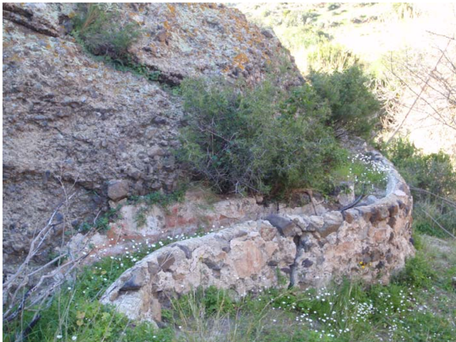
Acequia junto al cauce del Barranco de las Negras (Juan Carlos Rubio Campos)
